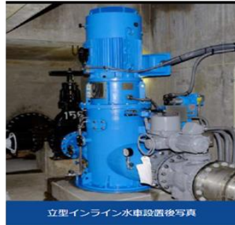
図 6-2-15 縦型水車による省スペース化の事例 出典:田中水力(株)
